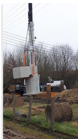
*Installation du Poste de refoulement au bas de la rue de la Vallée avec un camion grue.*
