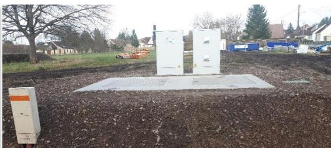
*Installation du poste de refoulement qui transfère les eaux usées chemin du Tremblay vers la station*
